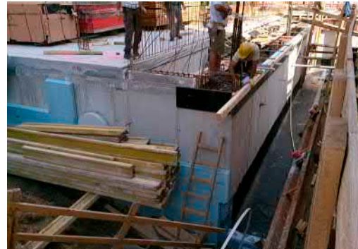
Bau der weißen Wanne des Erweiterungsbaus
