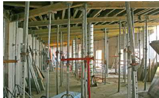
Die Schalung der schrägen Dachdecke
