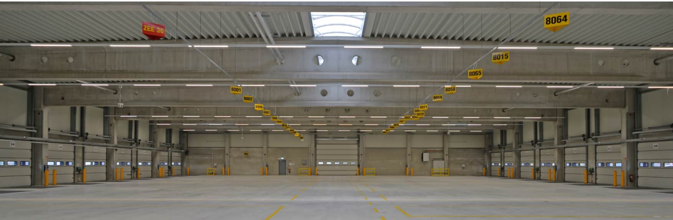
Fotografie: HKA Architekten Ammon & Kanthak PartGmbH
