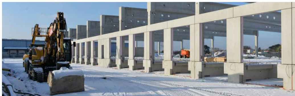
Die Halle nach Abschluss der Rohbauarbeiten
