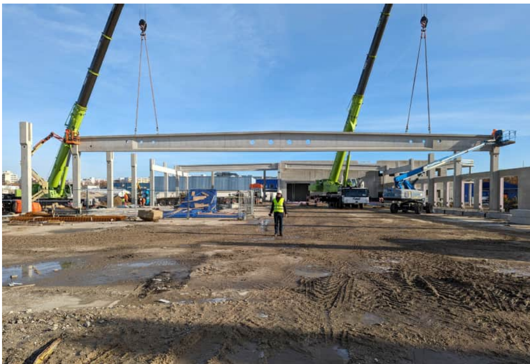
Fertigteilebinder im Bauzustand
