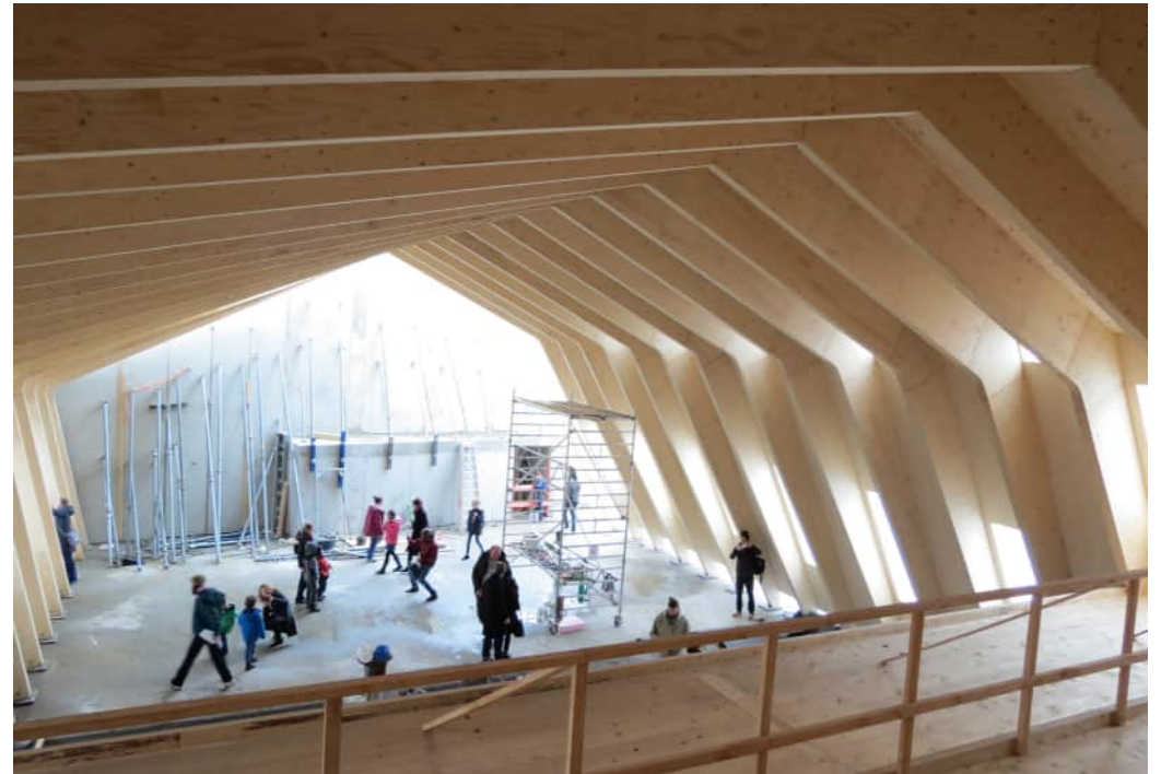
... und während des Innenausbaus
