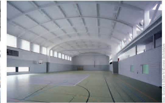
Halle nach der Fertigstellung
