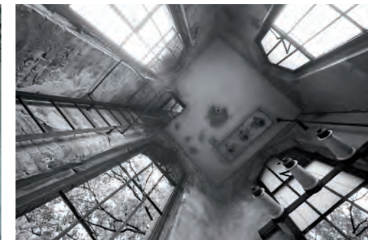
Bestand, Blick in den Turm
