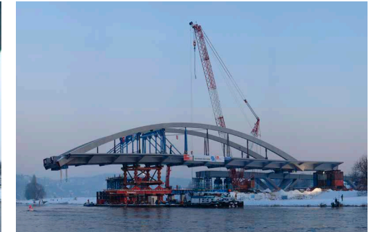
Einschwimmen des Brückens Bogens
