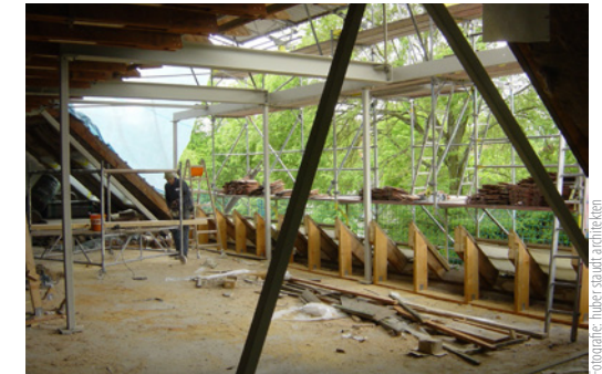
Einsetzen der Stahlkonstruktion für die Dachgaube
