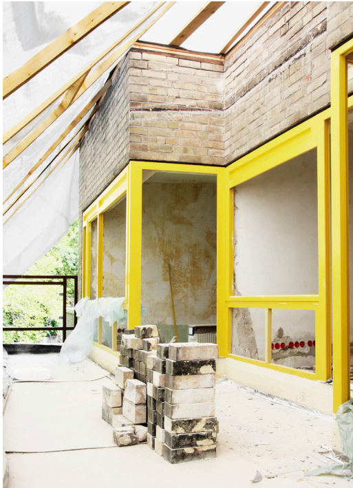
Bauarbeiten an der Fassade...
