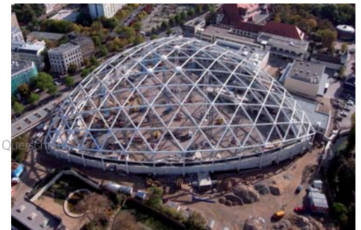
Montagestand primäre Tragstruktur, Halle im Ausbau
