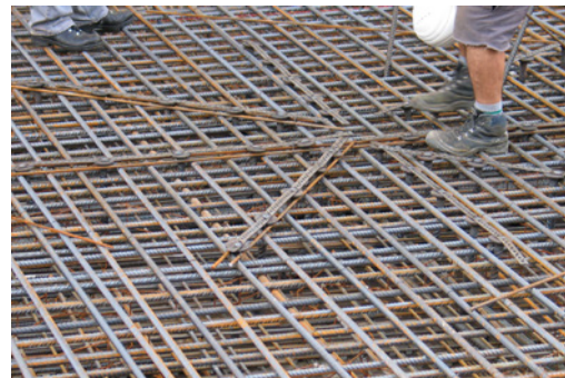
Bewehrungsmatten im Erdgeschoss
