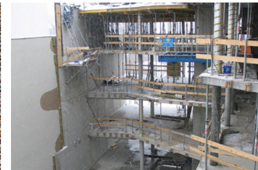
Das Gebäude im Rohbau
