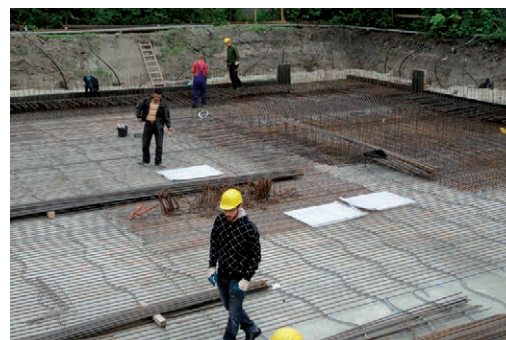
Blick in die Baugrube während der Fundamentarbeiten
