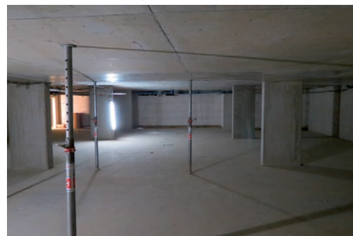
Innenansicht der Tiefgarage im Rohbauzustand
