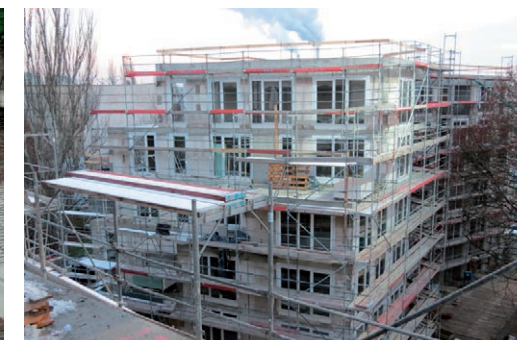
Das Gebäude im Bauzustand
