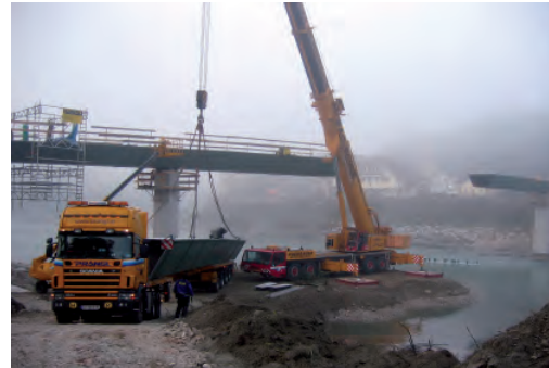
Einheben des letzten Brückenelements
