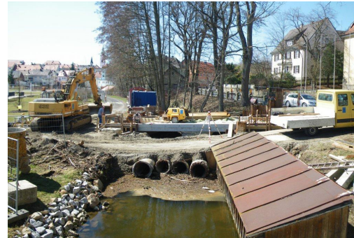
Baustelleneinrichtung und Wasserhaltung
