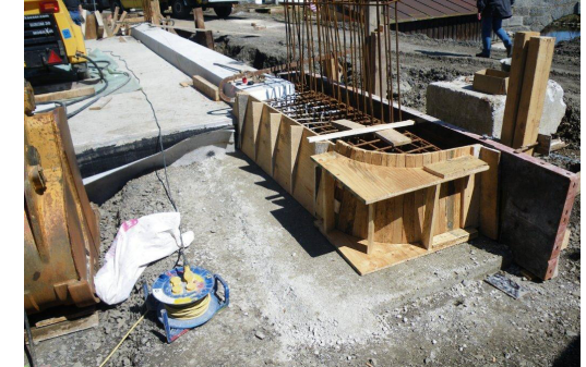
Bewehrung und Schalung der Absturzsicherung
