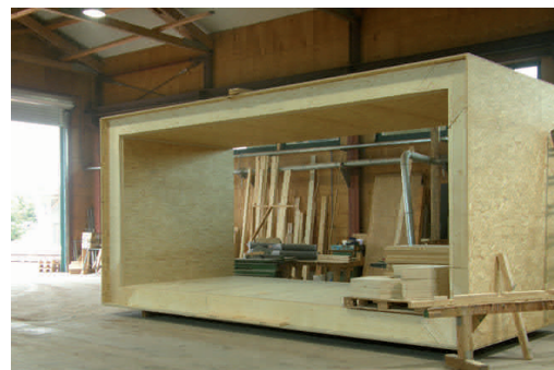
Vorfertigung der Module
